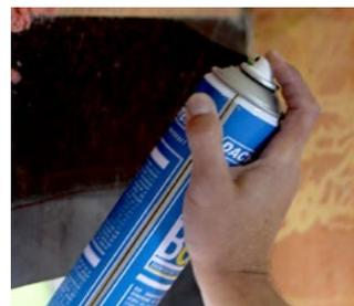
Es wird empfohlen, die Dachbahn vor der Verklebung zu kontrollieren. Evtl. können bei der Verlegung Beschädigungen durch spitze Gegenstände entstehen. In diesem Fall kann die Dachbahn mit Nahtabdeckband oder Formband und EPDM Aktivierung auf der Unterseite (und damit von oben nicht sichtbar) repariert werden.
