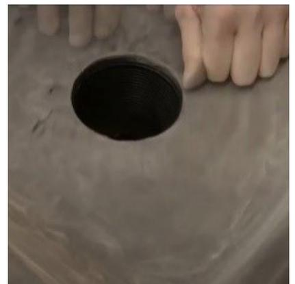
**5** Abschließend wird **an der Schnittkante der Anschlusskleber FLEX** vorsichtig mit dem Finger sichtbar **zu einer feinen Raupe unter der Dachbahn herausgedrückt.**
