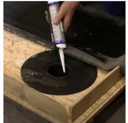
**4** Auf der Flanschoberseite nun **3 geschlossene Raupen vom Anschlusskleber FLEX (Durchmesser ca. 8 - 10 mm) aufbringen** und die Dachbahn über den Gully legen. **Die Dachbahn leicht andrücken und das Loch ausschneiden.**
