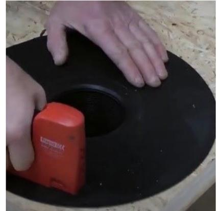
**2** Der Gully wird nun **mechanisch fixiert** und mit einem Tuch gereinigt.
