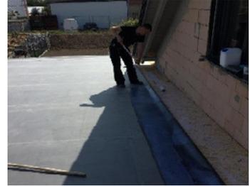
**2** **Im Randbereich** sowohl auf den Untergrund und ca. 15 cm Wand als auch **auf die Unterseite** der zurückgeschlagenen Dachbahn den **Flächenkleber SprayBond gleichmäßig und dünn auftragen**. Die **Oberflächen** werden nach **frühestens 2 bis 4 Minuten/spätestens 40 Minuten unter Druck** zusammengefügt.
