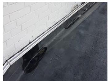
**6** Abschließend wird die **Wandanschlussleiste (Kappleiste)** montiert und **oberseitig** mit einer **Siliconfuge** versiegelt.
